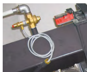
Sécurité thermique supplémentaire par vannes d'aspersion
