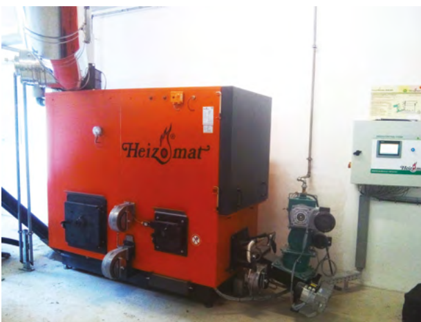
HSK-RA 200 X2 Commune de Queige (73) Réseau de chaleur communal Chaufferie avec 2 chaudières, trémie double de remplissage et 2 vis de répartition.
