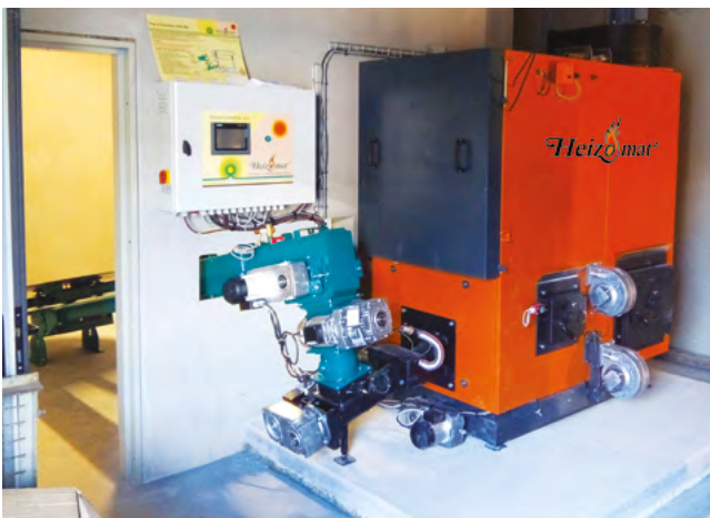
HSK-RA 150 Rennes Métropole (35) Chauffage des ateliers du métro de Rennes
