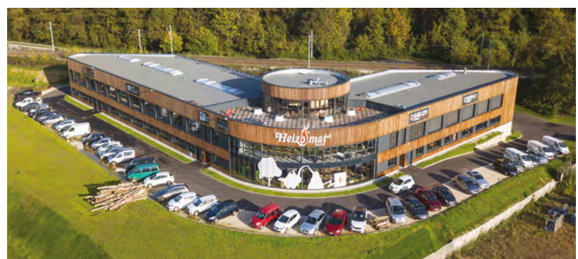
Nouveau siège et base technique et commerciale en Savoie (73) en bordure de l'A43
