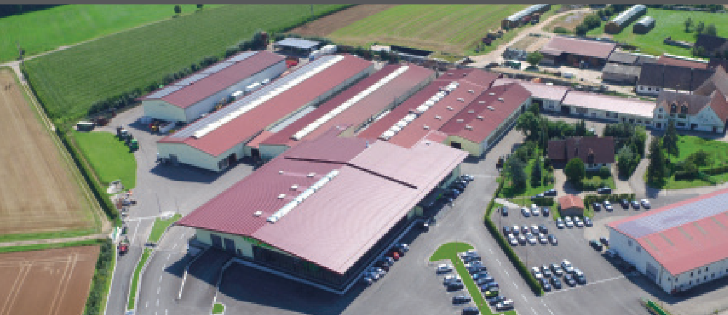
Site de MAICHA : 13 000 m 2 , assemblage final des broyeurs
